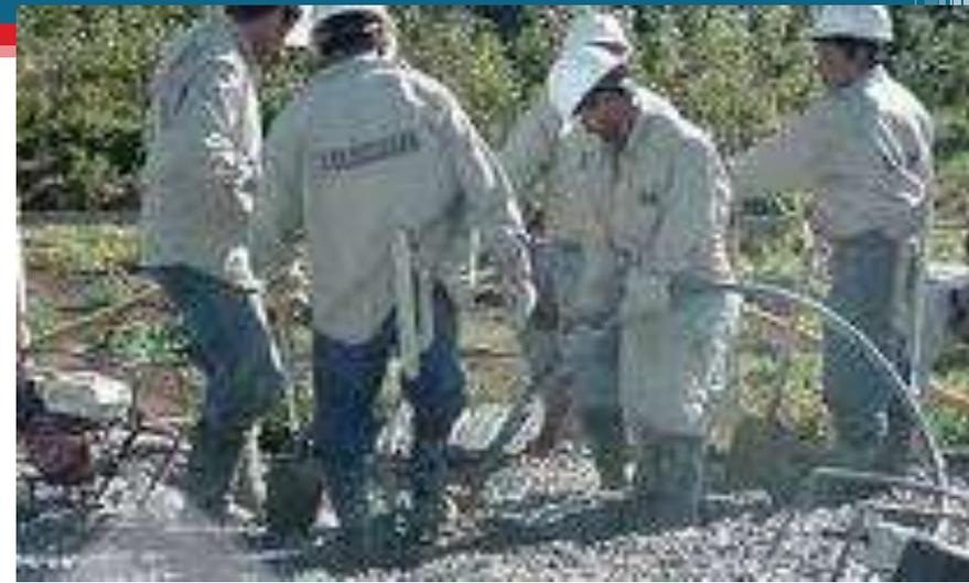
**C.5.10.5** — Una vez iniciada la colocación del concreto, ésta debe efectuarse en una operación continua hasta que se termine el llenado del panel o sección, definida por sus límites o juntas predeterminadas, excepto en lo permitido o prohibido por C.6.4.
